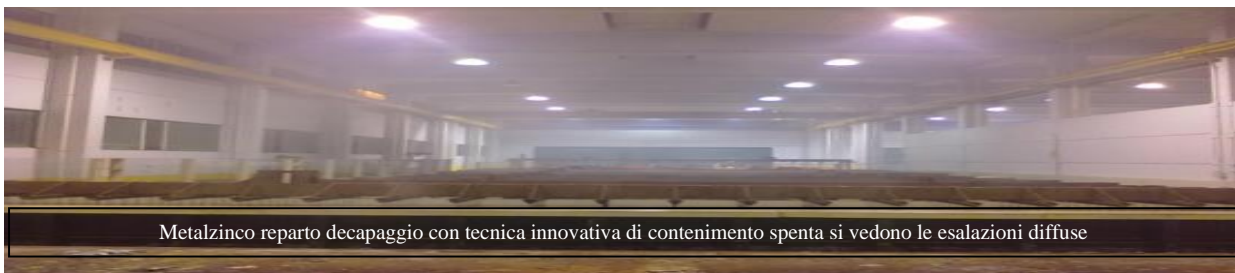
IMPIANTO DI CONTENIMENTO FUMI DI DECAPAGGIO SPENTO
